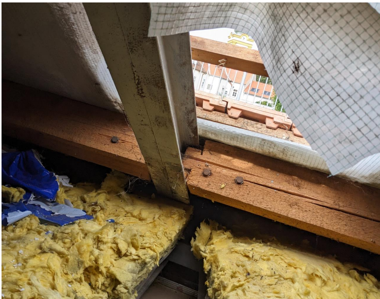
Obrázek 2 – Detail napojení vaznic na ocelový rám
